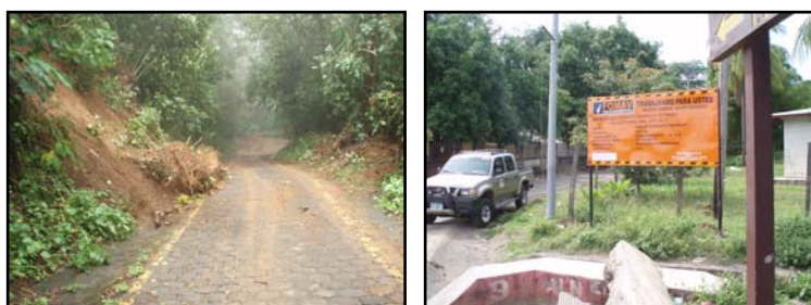
Mantenimiento del camino adoquinado
